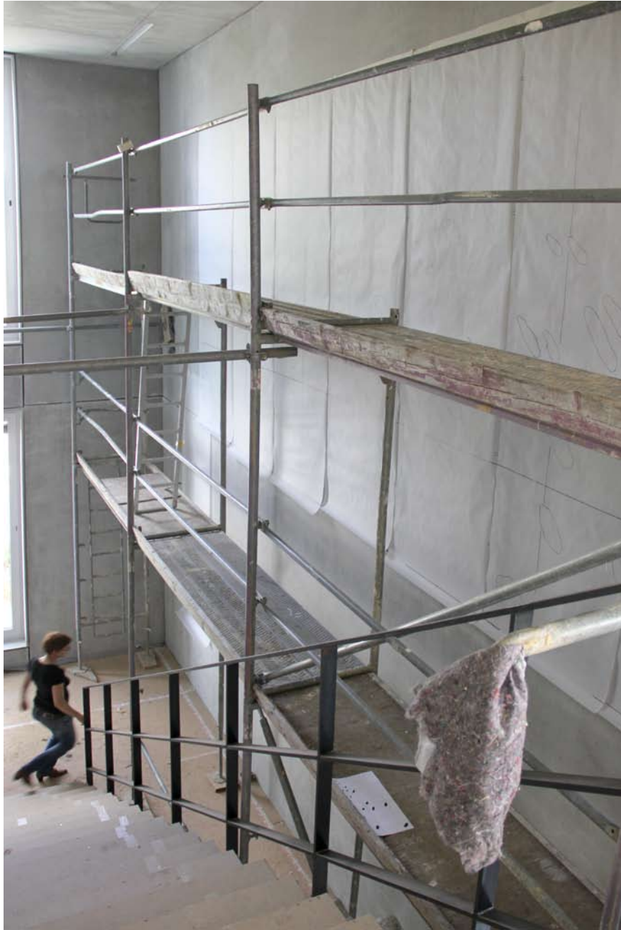
Arbeitssituation Treppe Nord
